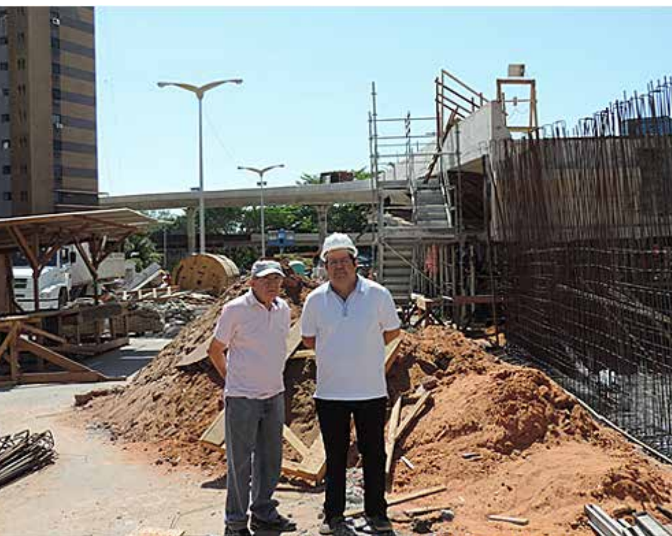
Dr. Hugo e Dr. Joaquim nas obras do Viaduto do Cocó
